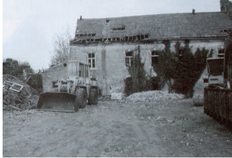
Afbraakwerken aan het Elzenklooster – foto van 25 april 1990
